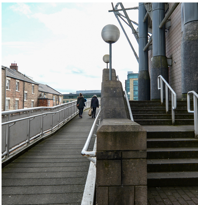
Abbildung 11. Zugangsrampe in der südöstlichen Ecke
