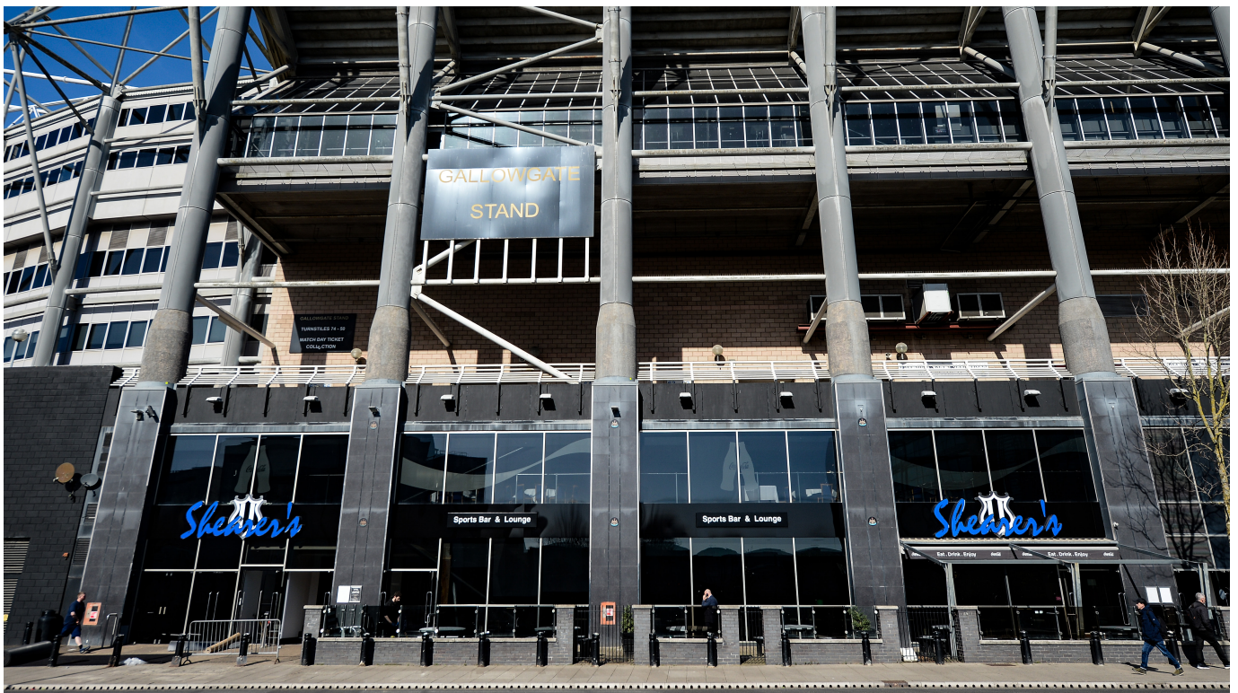
Abbildung 23. Rampe zu „Shearer’s Sports Bar“ mit Zugangshilfe
